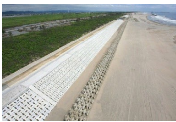
海岸堤防の復旧状況
