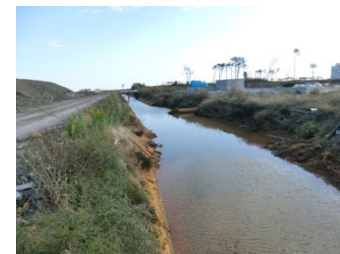
【仙台東】大堀排水路
