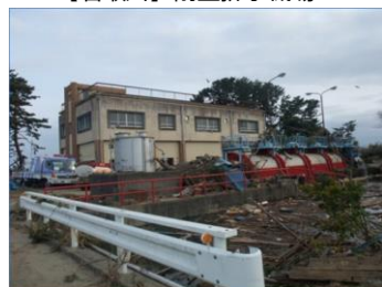
【名取川】関上排水機場
