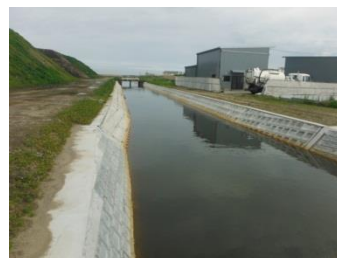
津波で損壊した排水路の復旧状況
