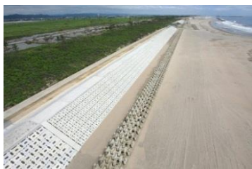
海岸堤防の復旧状況
