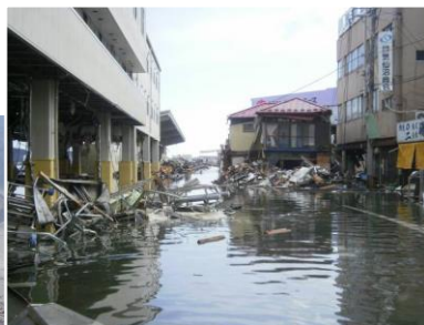
浸水した荷さばき所背後
