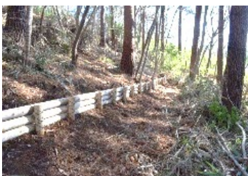
丸太を活用した土壌流出防止柵の設置
