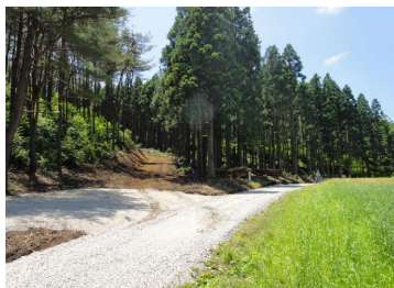
間伐と森林管理に必要な作業道を整備
