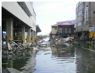
浸水した荷さばき所背後
