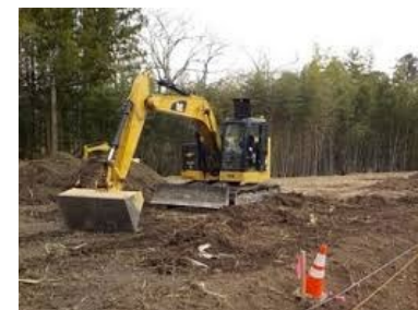
浪江町の特定復興再生拠点区域での表土の剥ぎ取り 出典: 環境省除染情報サイト
