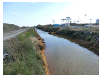
【仙台東】大堀排水路
