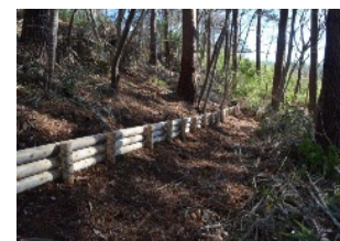
土砂移動抑制のため、筋工を施工
