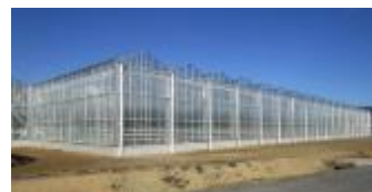
高軒高のガラス温室
