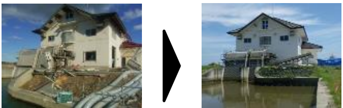
排水機場の復旧状況(谷地排水機場)
