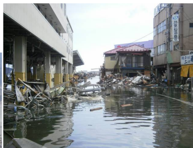
浸水した荷さばき所背後
