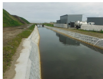
津波で損壊した排水路の復旧状況
