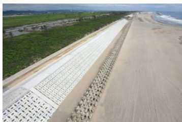
海岸堤防の復旧状況
