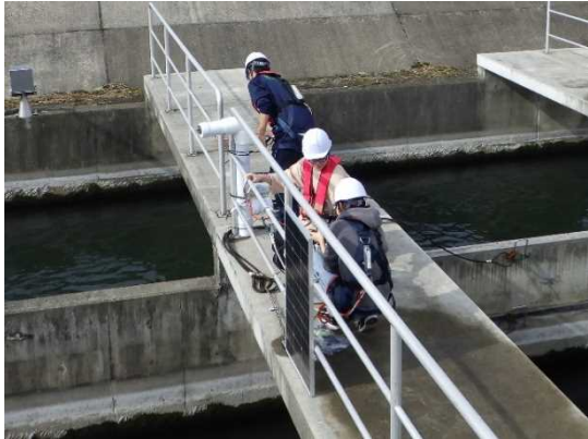
写真-1 武蔵水路での群馬高専のI o Tセンサ設置状況
