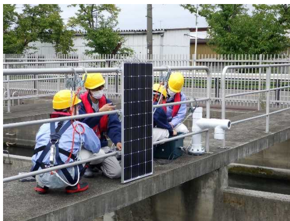
写真-1 武蔵水路での群馬高専のI o Tセンサ設置状況
