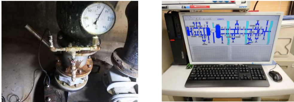
写真-3 霞ヶ浦用水 (左: 圧力センサー設置状況、右: 圧力監視装置)
