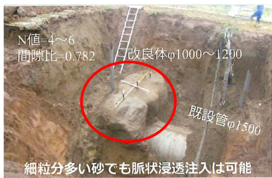
既設管路の浮上防止構造
