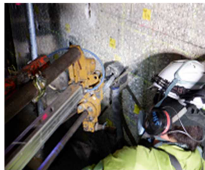
写真－1 耐震補強工事実施状況（左：利根大堰、右：朝霞水路）
