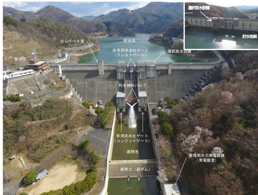
図－１ ダムの基本的な設備例（一庫ダム：重力式コンクリートダム）
