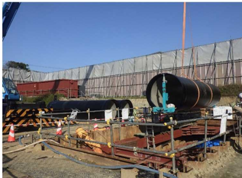
写真-6 水路改築工事実施状況（左：鋼管吊込状況、右：ダクトイル鉄管接合状況）
