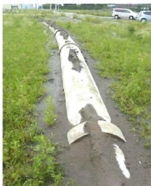
液状化によるパイプラインの浮上
