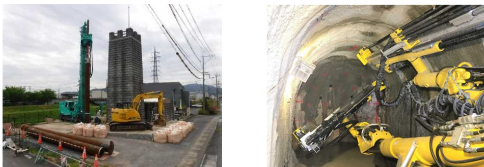
写真－4 耐震補強工事実施状況 (左：基山調圧水槽基礎補強工事、右：2号トンネル併設水路工事)
