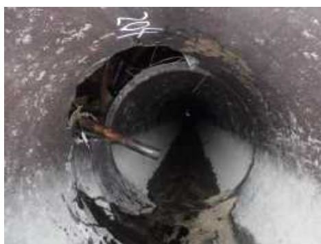
写真-8 PC管損傷状況
