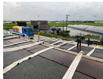
60m 3 /minポンプ車排水作業
