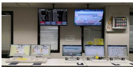
布目ダム管理用制御処理設備（更新後）
