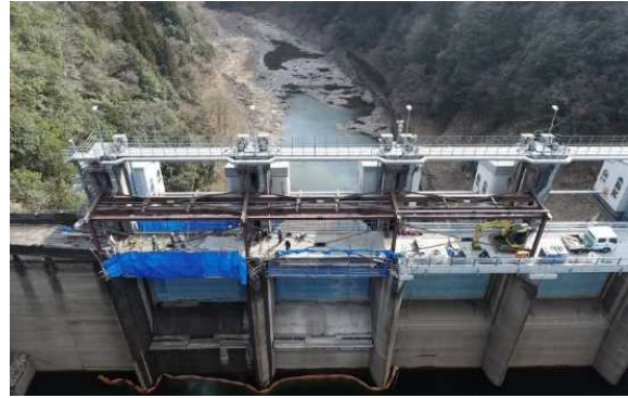
予備ゲート改良（天端橋梁取り壊しなど）の実施状況（左：施工前、右：施工中）
