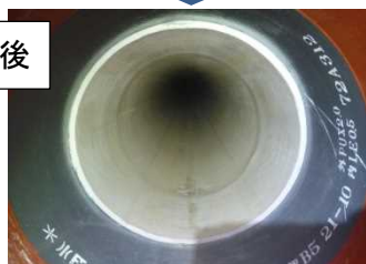
写真－2 機能保全対策（管更生工法）の実施状況（三重用水）
