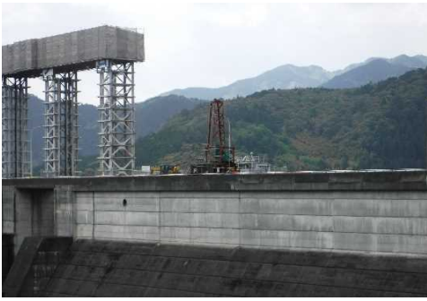
(準備工事：観測設備移設(ブラムライン)工事)
