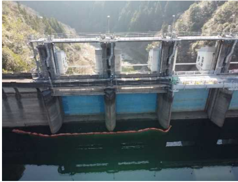
予備ゲート改良（天端橋梁取り壊しなど）の実施状況（左：施工前、右：施工中）
