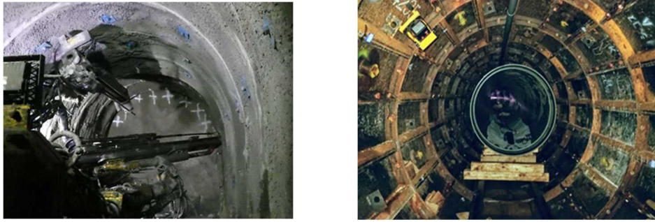
写真－2 併設水路工事実施状況 (左：東部幹線併設水路浅間・風越併設水路工事、右：西部幹線併設水路豊岡工区工事)
