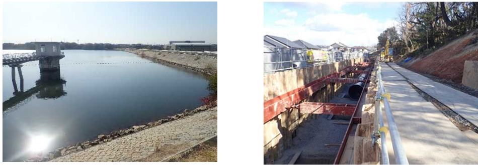
写真－3 改築工事実施状況（左：三好池堤体補強[完成]、右：三好支線水路改築）
