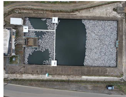
写真-5 改築工事実施状況（左：制水弁更新工事、右：ファームポンド分画化工事）
