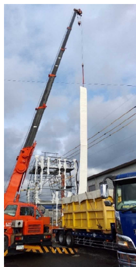
写真－2 機能保全対策（管更生工法）の実施状況（三重用水）
