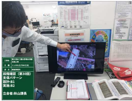
写真-2 遠隔臨場による切羽判定状況 (左: 大野導水併設水路工事 右: 浅間・風越工区工事)
