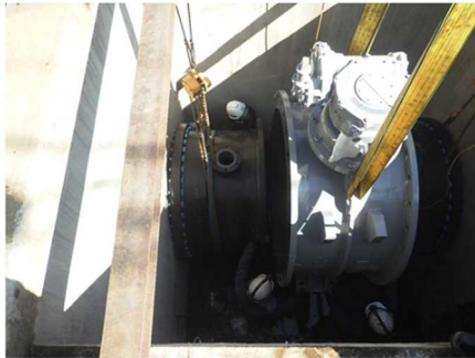
写真-5 改築工事実施状況（左：制水弁更新工事、右：ファームポンド分画化工事）
