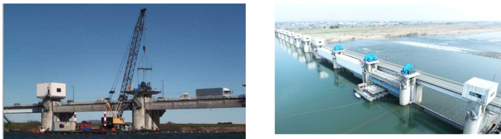
写真-8 利根大堰開閉装置更新実施状況 (左：開閉装置据付状況、右：更新後の開閉装置)
