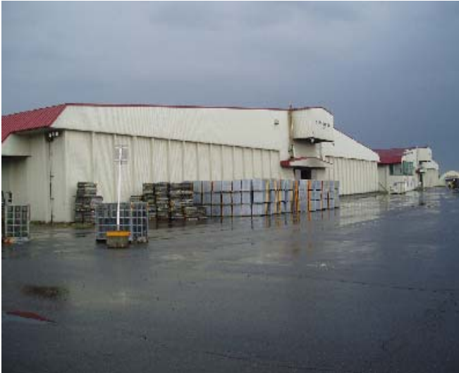
JA 土幌町の馬鈴しょ貯蔵庫 (庫内は両側に各 4 室に分かれており、全体で約 1 万 4 千 t 収容可能)
