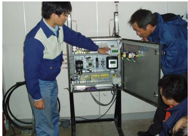
エチレングス制御装置 (英国製) (JA 帯広かわにし 700t 貯蔵庫×2～4 室制御可能： 平成 21 年 5 月 14 日現在)
