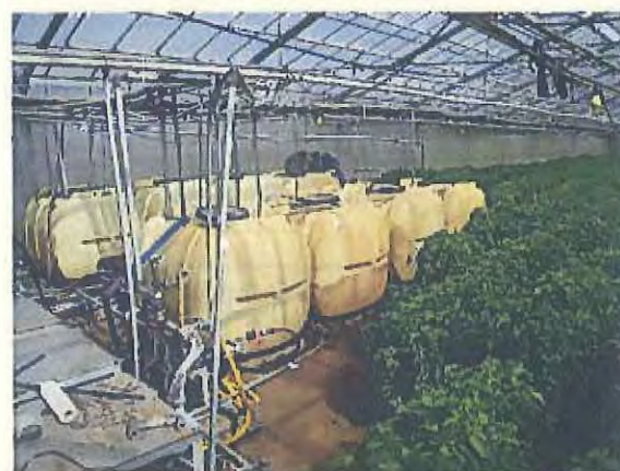
写真3 C電解次亜塩素酸水タンク
