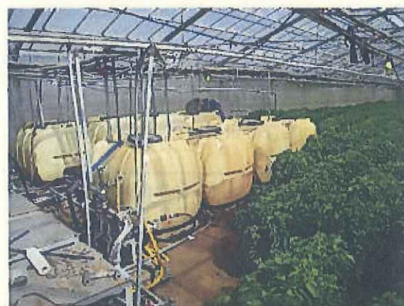
写真3 C 電解次亜塩素酸水タンク
