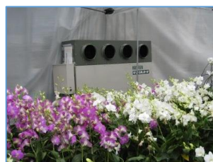
安定的採熱と ヒートポンプ利活用
