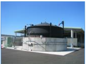
バイオガス発電
