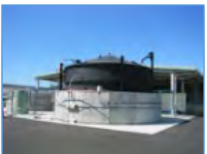
バイオガス発電
