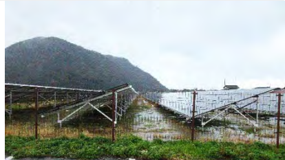
発電施設の外観
