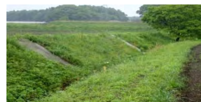
熊本地震後の大雨で崩れた 用水路の法面の補修
