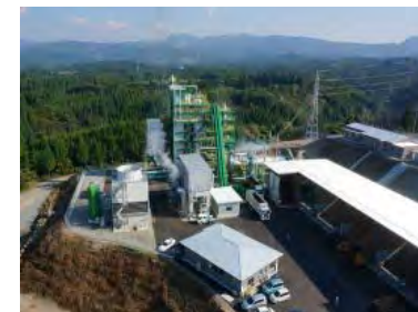
発電施設の外観
