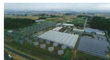
発電施設の外観
