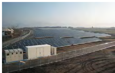
発電施設の外観
