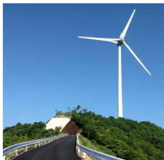
発電施設の外観
