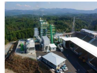
発電施設の外観
