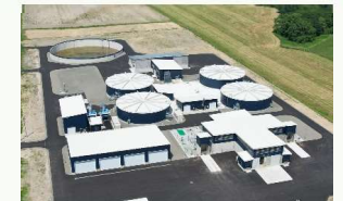
バイオマスプラント
