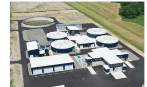
バイオマスプラント
