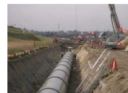
水路のパイプライン化
