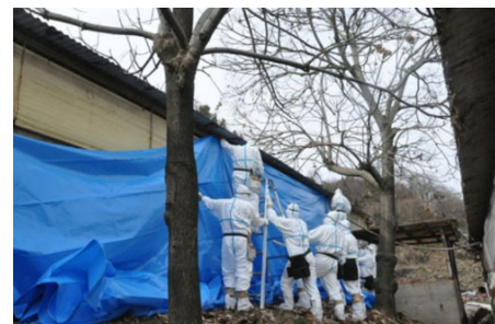
畜舎へのブルーシート設置
