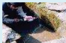
水路のひび割れ補修
