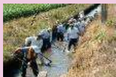
水路の泥上げ
