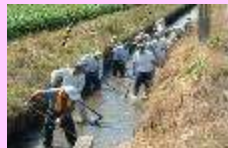
水路の泥上げ
