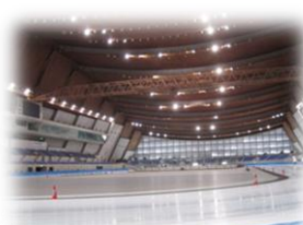
事例：エム・ウェーブ（長野五輪スケート競技施設） 国産カラマツの集成材を屋根構造に使用
