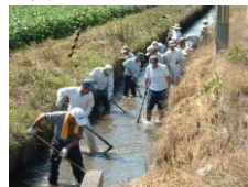
水路の泥上げ
