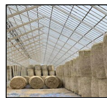
簡易倉庫の設置
