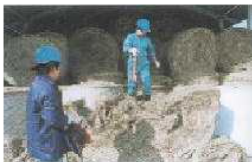
② ヘイカッターで解体する
