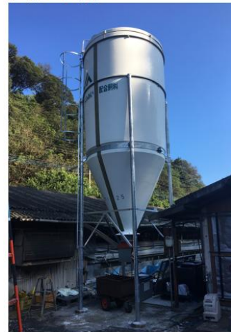
写真① 良好な状態
