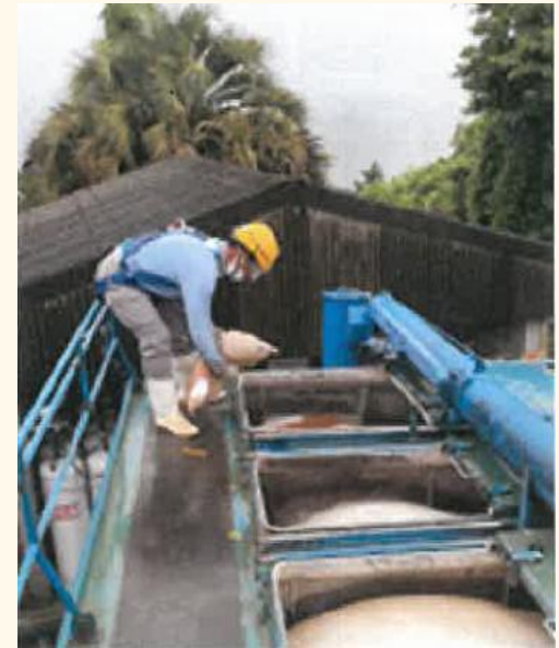
バルク車の天井開口部で 添加剤等を手作業で投入
