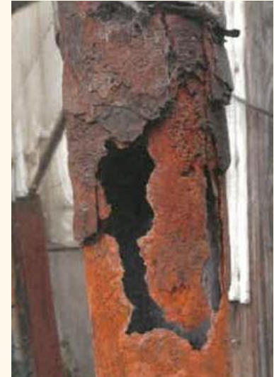
腐食した飼料タンクでの 作業も発生
