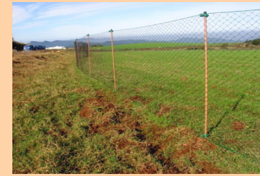
⑥ 物理柵(ワイヤーメッシュ・金網) ・特に地際に隙間を作らない！
