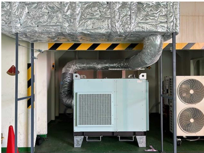
図7 10馬力空調機設置図
