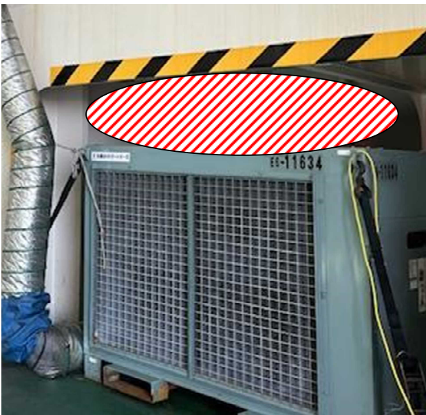
図5 20馬力空調機設置
