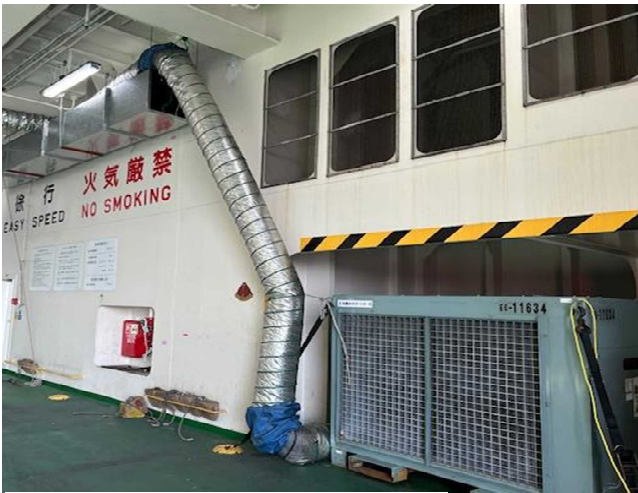
図2 20馬力空調機設置
