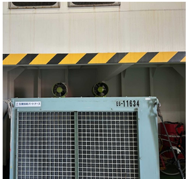
図6 サーキュレーター設置図
