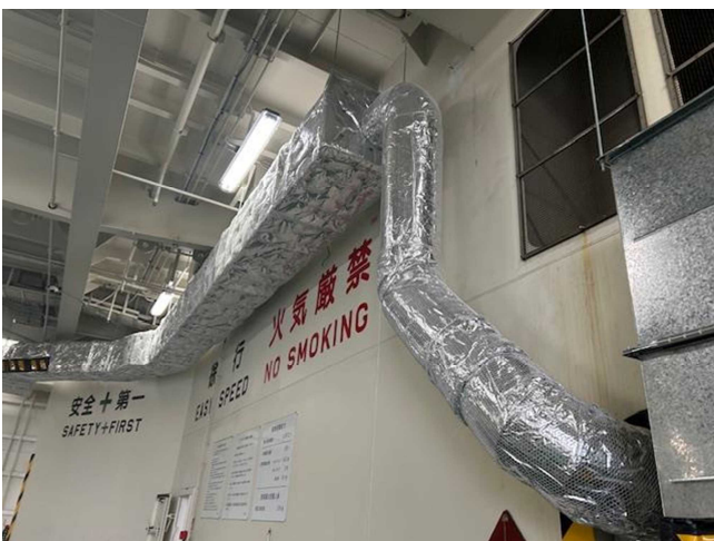
図23 車両甲板内ダクト（変更後）
