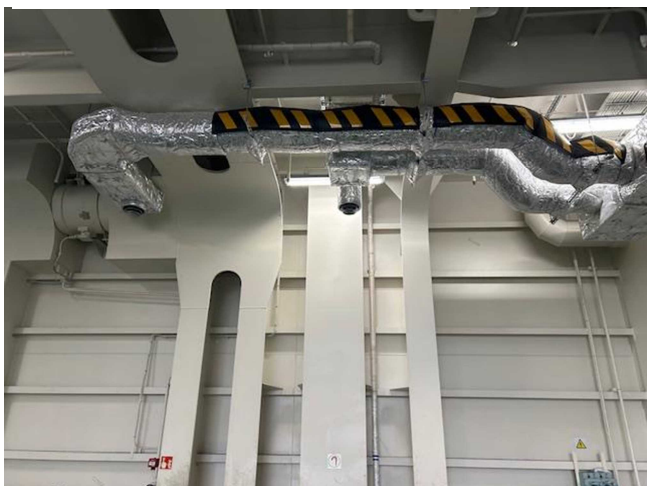
図24 車両甲板内ダクト（変更後）
