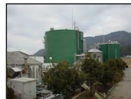
【メタン発酵施設】
