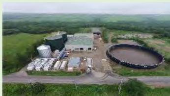
メタン発酵バイオマス発電
