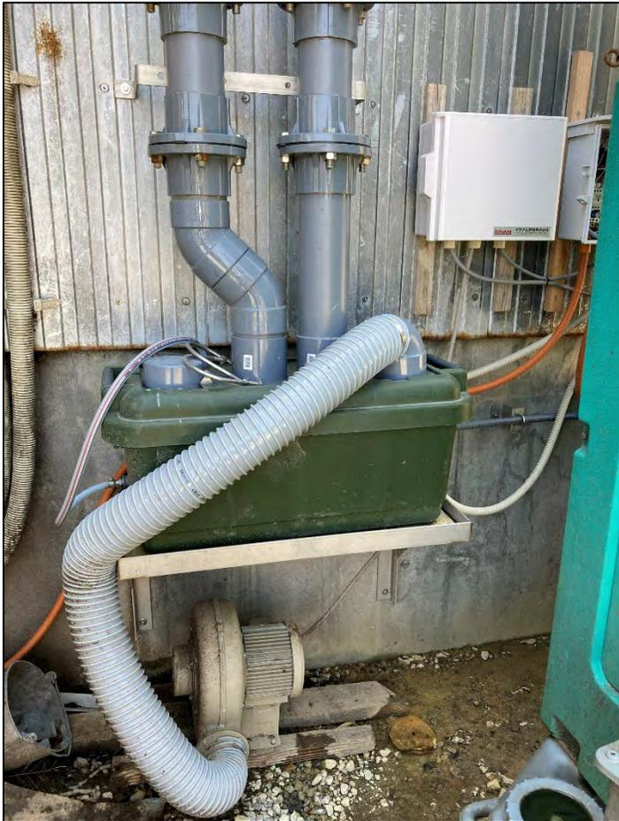
超音波で次亜水を気化する装置
