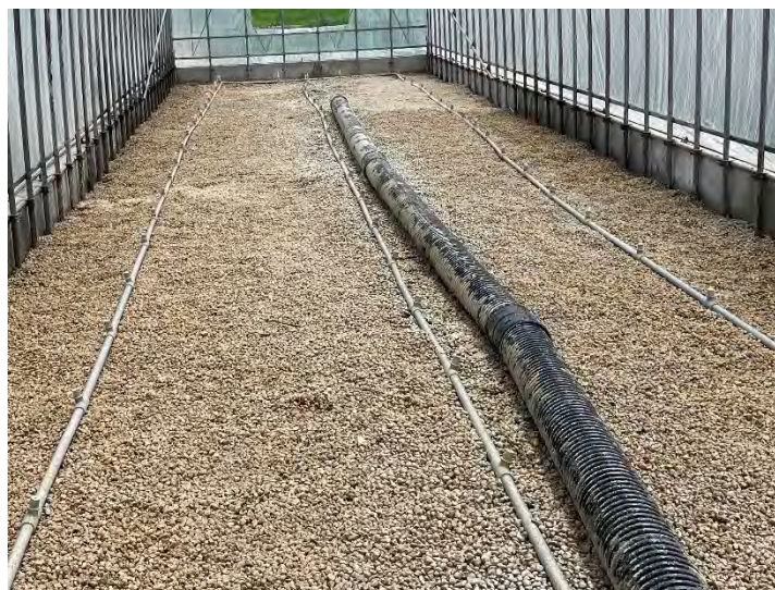
脱臭装置の内部
