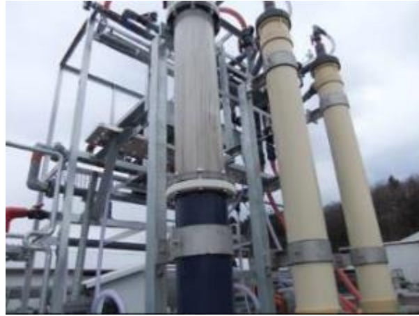
図 18. 外付け型膜モジュールの設置状況
