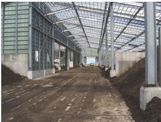
写真 3 第二次堆肥処理施設
