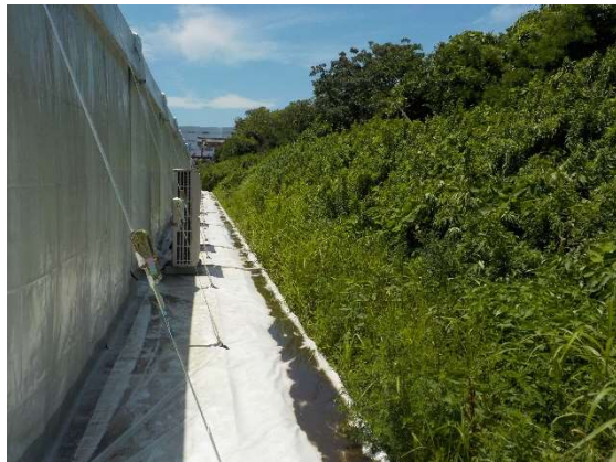
駐車前植林地(厩舎周辺)
