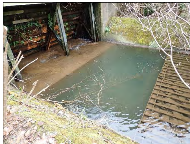
水叩部と鋼製枠の手前水面下に砂止壁。
