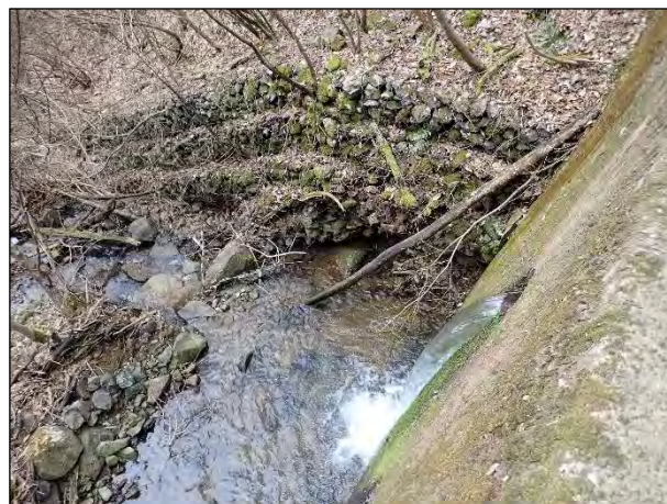
上流治山ダム水抜きからの表流水。
