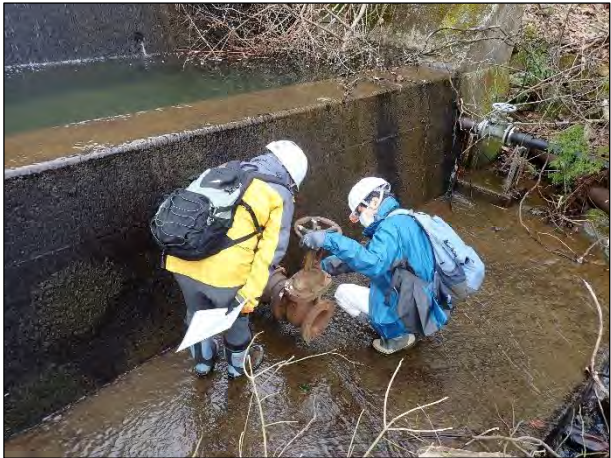
集水桝の排泥弁。
