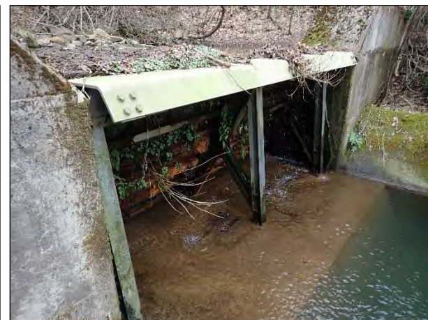
鋼製スクリーンダムから滴下する表流水。
