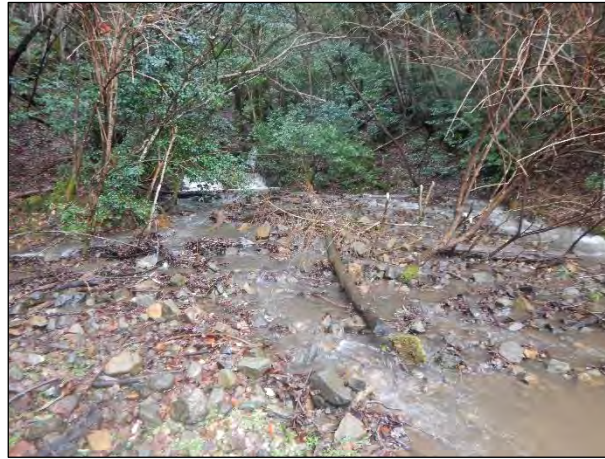
上流治山ダムの堆砂敷 容易に濁水が発生する。
