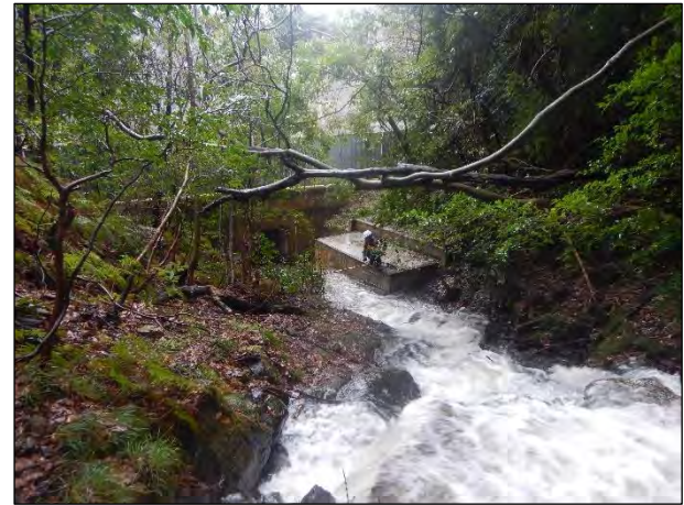
隣接溪流にある主水源の取水口。
