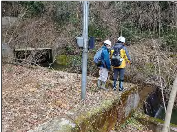
湛水部と左岸作業空間。
