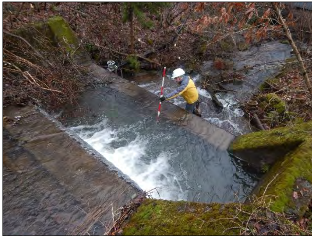
平水時の取水桝と原水取水弁と導水パイプ。
