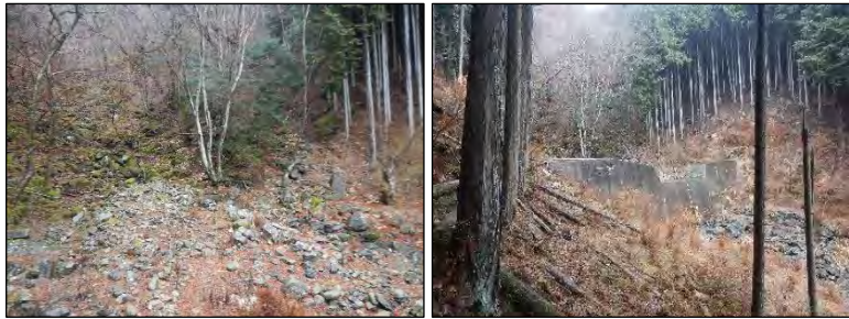
荒廃状況(1) 支流は谷止工群で安定傾向
