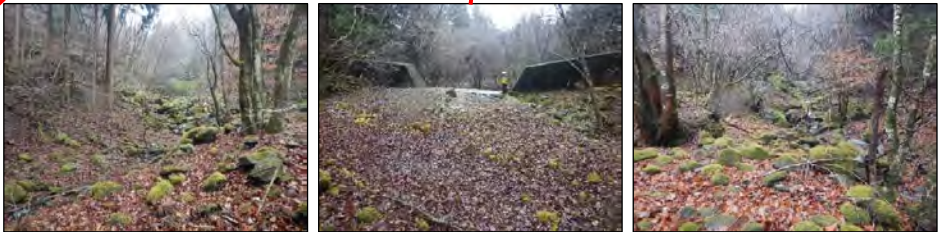
荒廃状況(4) 合流点の土砂堆積状況は安定している。
