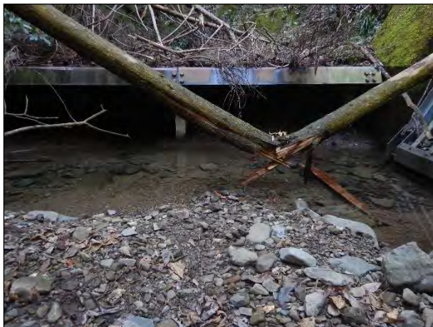
鋼製スクリーンダムの下流状況(湛水している)
