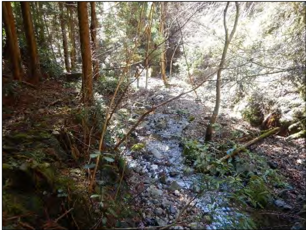
鋼製スクリーンダムの堆砂敷(表流している)
