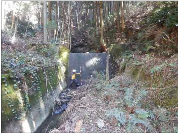
治山ダム(流路工の上流始端)
