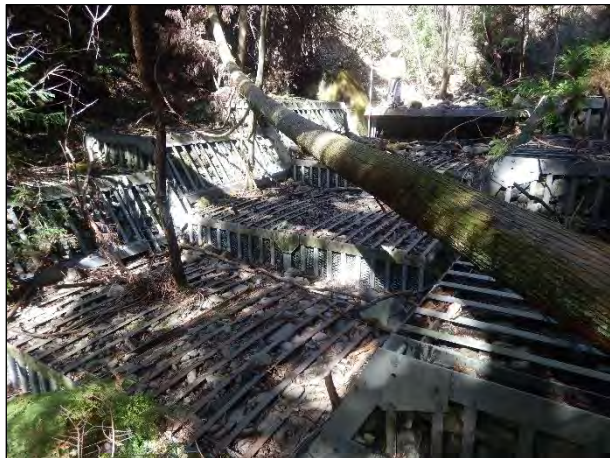
鋼製柵の流路部(表流水はなし)
