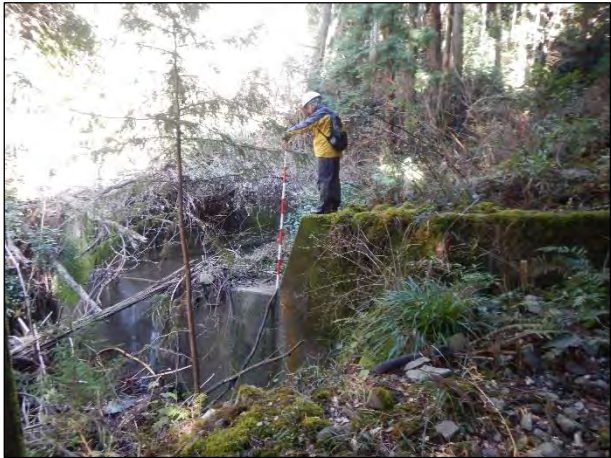
治山ダム(流路工の下流末端)
