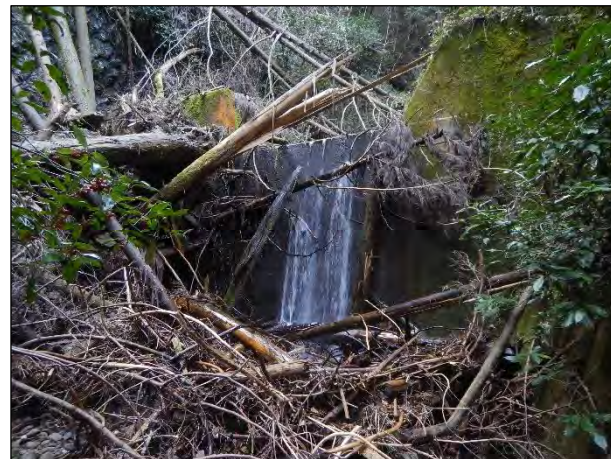
上流部の谷止工
