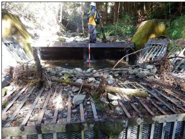
鋼製スクリーンダム直下の鋼製柵(表流水あり)
