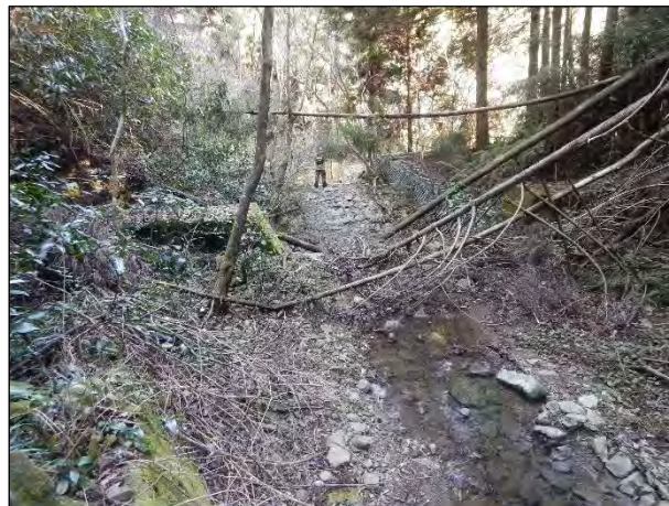
鋼製スクリーンダムの堆砂敷(表流水あり)
