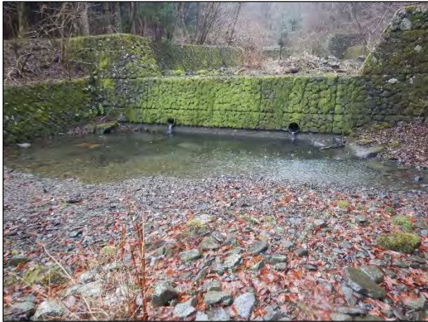
上流床固工水抜きからの流水
