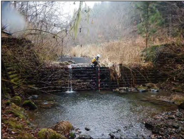
下流左上流方向(鋼製柵表面を表流している)
