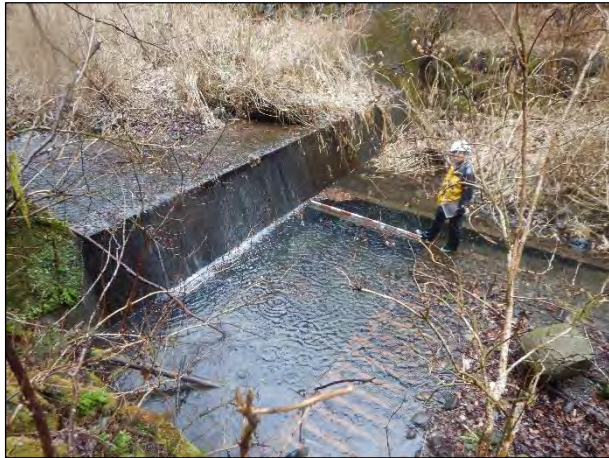
床固工水叩部(油圧開閉弁あり)
