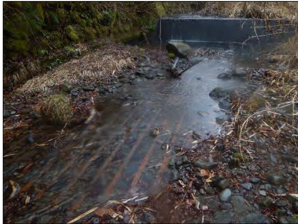
渓流水は鋼製柵表面を表流している
