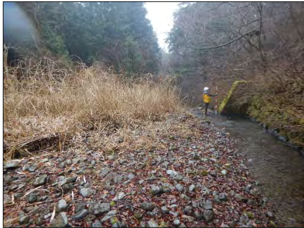
水質保全施設上部の床固工堆砂状況
