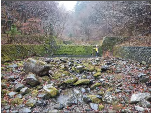
上流の床固工
