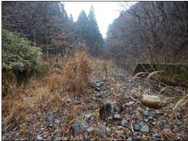
谷止工下部の床固工の堆砂状況
