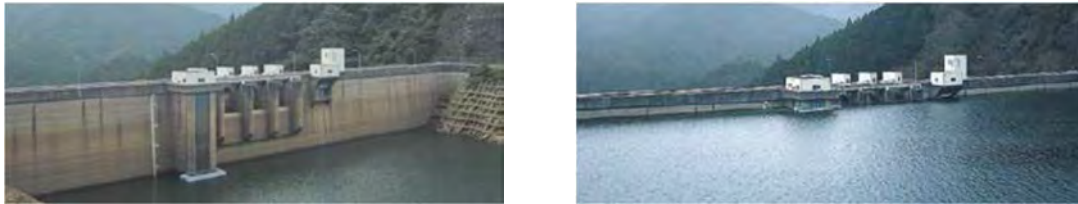
図-12 洪水調節のための農業用ダムの運用（左：台風に先立って貯水量を増やすために貯水位を低下させた状態、右：台風の流出水がダムに保持された様子）（国交省 25) より転載）
