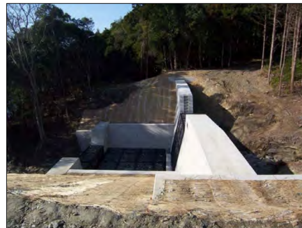
溪流②施設 左岸から右岸
