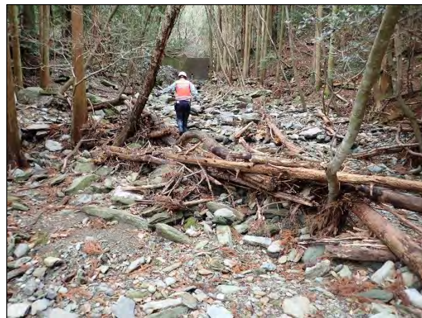
上流部は荒廃溪流で治山施設が配置されている
