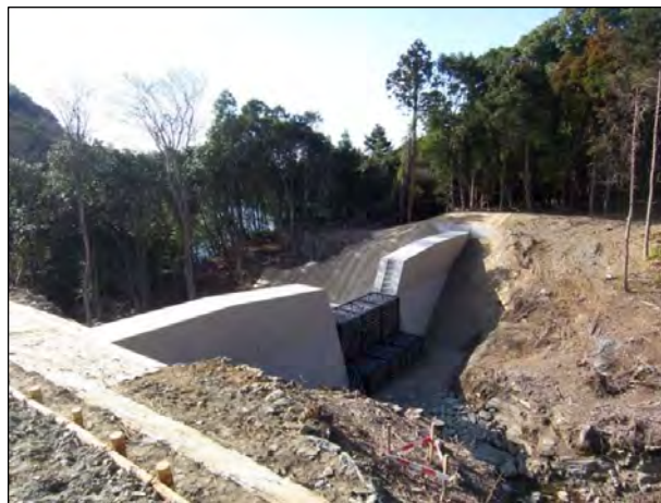
溪流②施設 上流左岸から下流右岸
