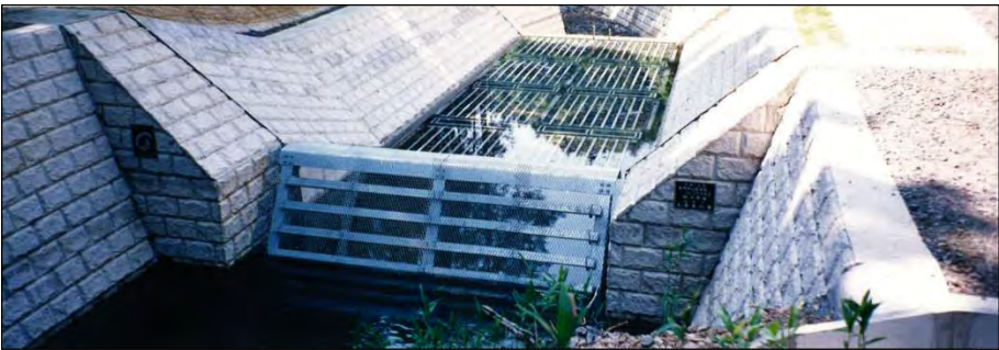
施工時の状況と浄化ユニット
