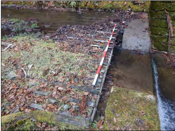
止水堤の複断面放水路と鋼製枠。
