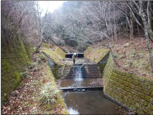
下流部から上流部方向。止水堤は20cm切欠き。
