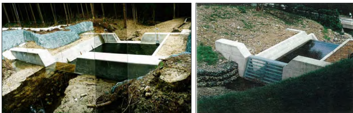
図 3.6 左:沈砂型施設の例 右:複合型施設(沈砂型+透過型)の例
