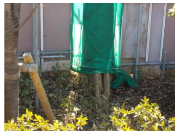
フェンスの隙間の仮補修
