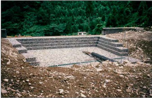
鋼製スクリーンダムの堆砂敷に形成されたポケット
