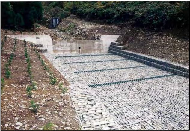
水質保全施設
