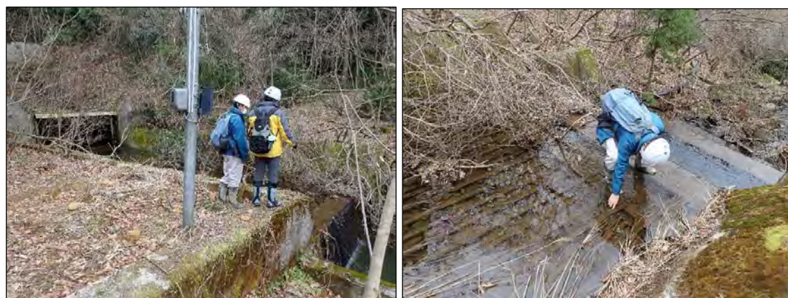
図 4.9 電源と木炭カードリッジの状況
