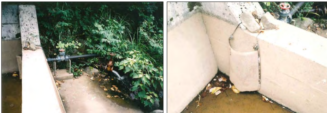
図 4.6 導水管交換前の状況(平成 17 年)
