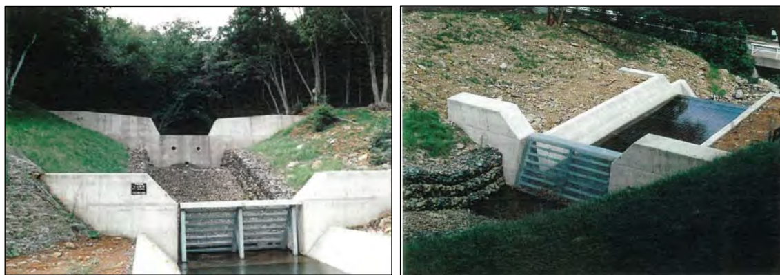
図 4.1 舞鶴市三浜の水質保全施設(施工直後)
