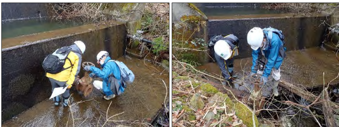
図 4.8 維持管理のための排泥弁稼働確認
