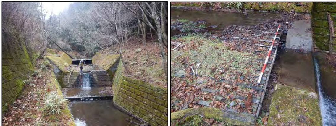
図 4.10 京都市山科区の水質保全施設(正面と止水壁の切欠部)
