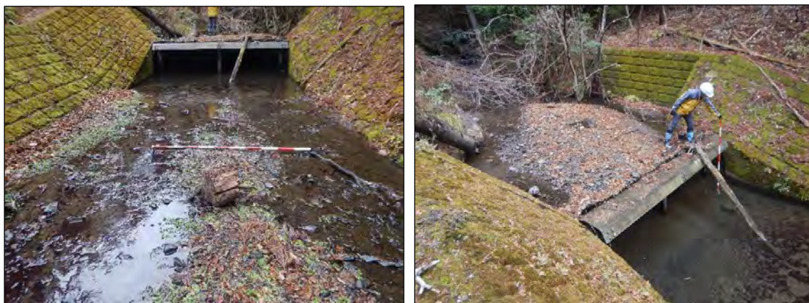
図 4.11 鋼製枠の表面流と鋼製スクリーンダムの堆砂敷
