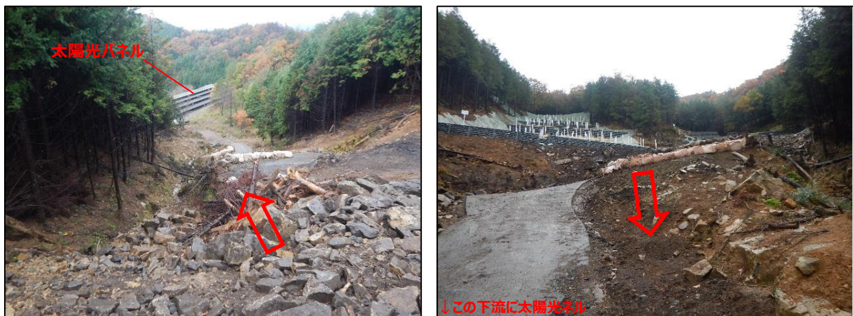
写真 5.7 域外からの土砂入流によって被災した事例
