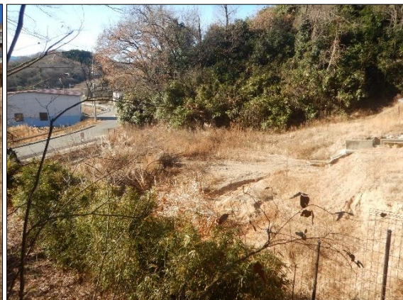
写真 5.2 沈砂池の埋没
