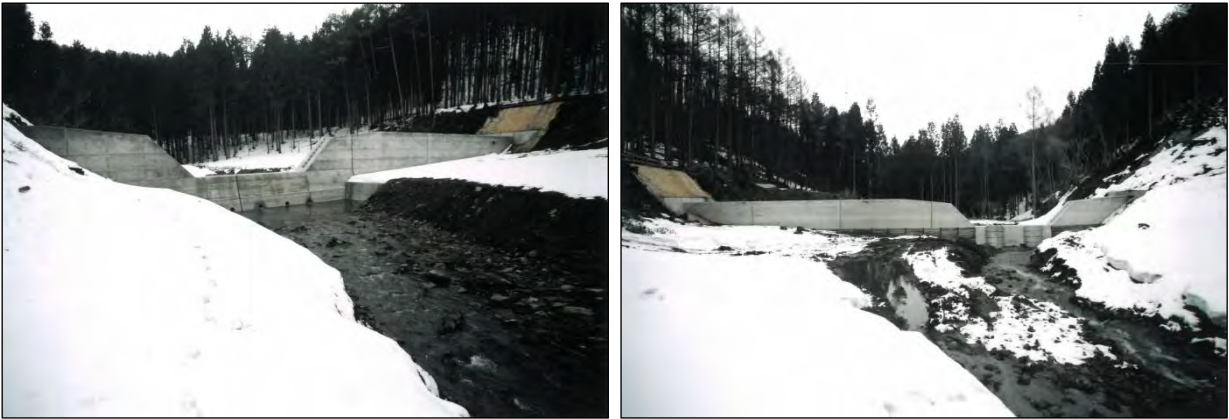
施工時の写真 左:下流右岸から上流方向 右:上流左岸から下流方向
