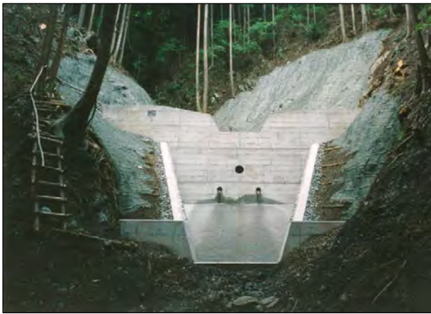
No.2治山ダム施工状況
