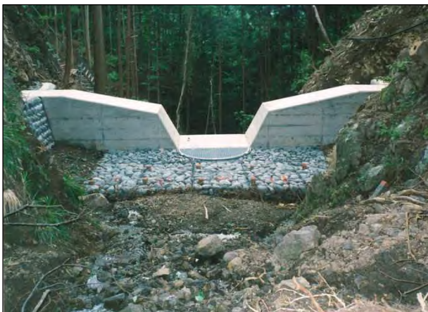
No.1治山ダム施工状況
