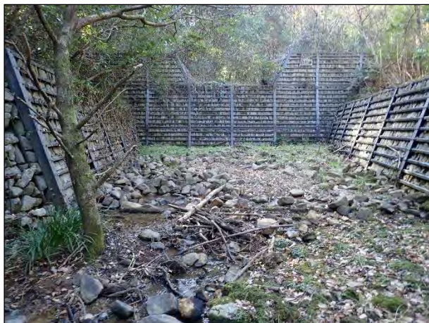
治山ダム正面。
