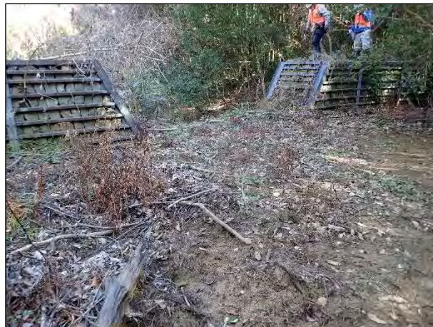
治山ダム堆砂敷。表流水はない。
