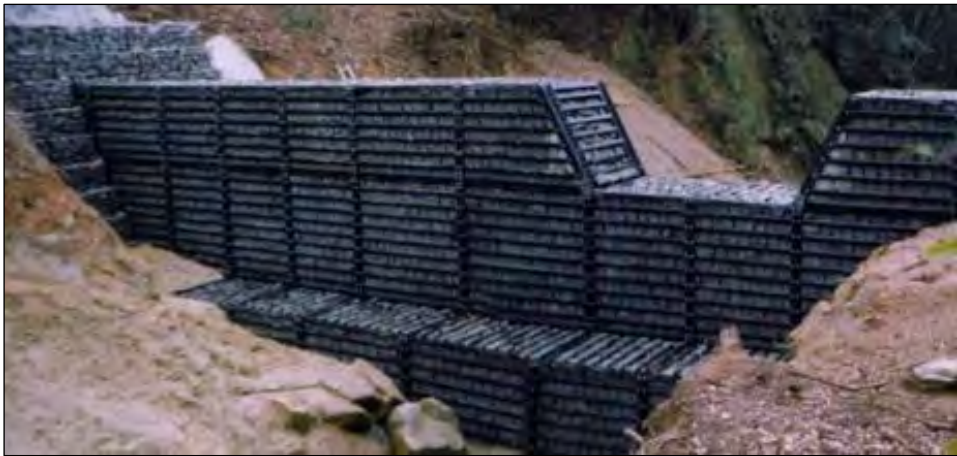
上流右岸から貯水池方向
