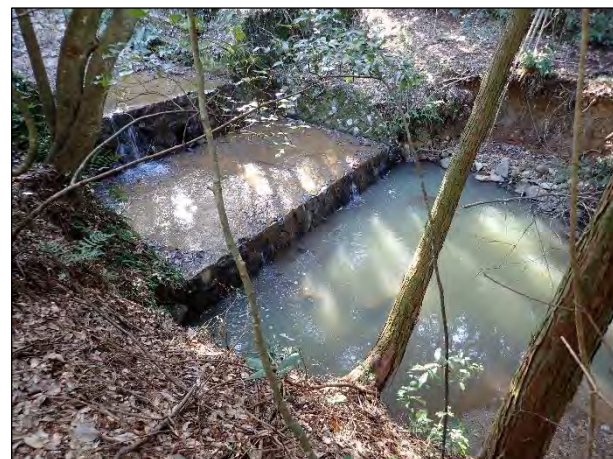
貯水池から水質保全施設までは濁水が発生。
