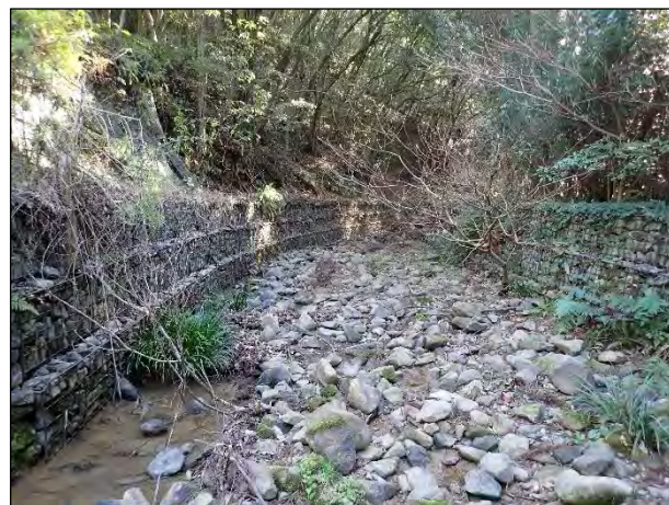
鋼製枠護岸工
