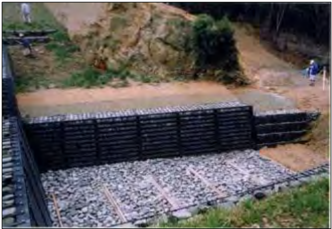
水叩の左岸側 水叩部は木製沈床構造
